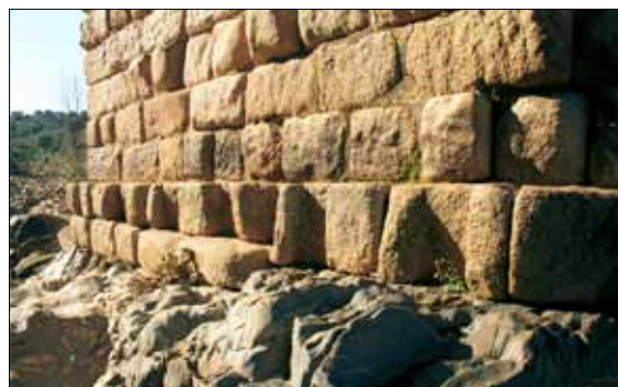
A la derecha, estado original de la fábrica del puente romano de Segura, en Cáceres. Dos mil años de estabilidad gracias a la perfecta unión de los sillares de granito rosado y a su apoyo en la roca madre. Arriba, desastre permitido por la Administración.
