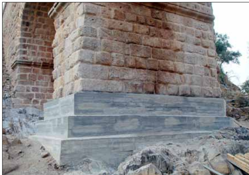
A la derecha, estado original de la fábrica del puente romano de Segura, en Cáceres. Dos mil años de estabilidad gracias a la perfecta unión de los sillares de granito rosado y a su apoyo en la roca madre. Arriba, desastre permitido por la Administración.
