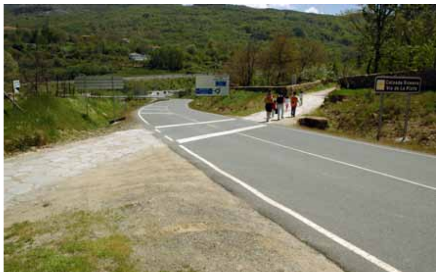
Promoción turística de la “calzada romana” de la Vía de la Plata sobre el trazado y sobre las estructuras del Camino Real de Castilla, en el puerto de Béjar (Salamanca).
